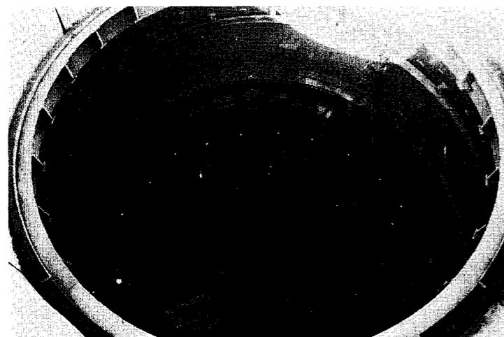
PCV (原子炉格納容器) 開口部
